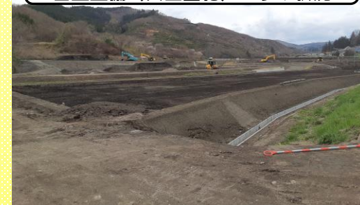
都路町内の 基盤整備（大区画化）工事の状況
