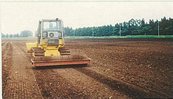
(ケンブリッジローラーによる整地・鎮圧)
